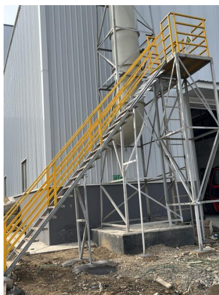
固化废气排气筒 DA005 即墨采样平台
