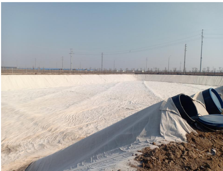
应急垃圾填埋场（飞灰填埋场）
