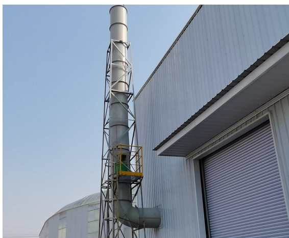
固化废气排气筒 DA005 即墨采样平台
