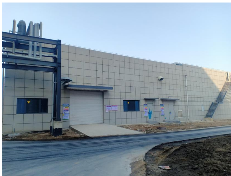
渗滤液处理站外部
