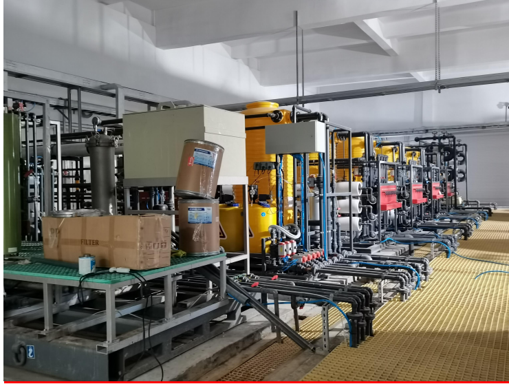
渗滤液处理站内部
